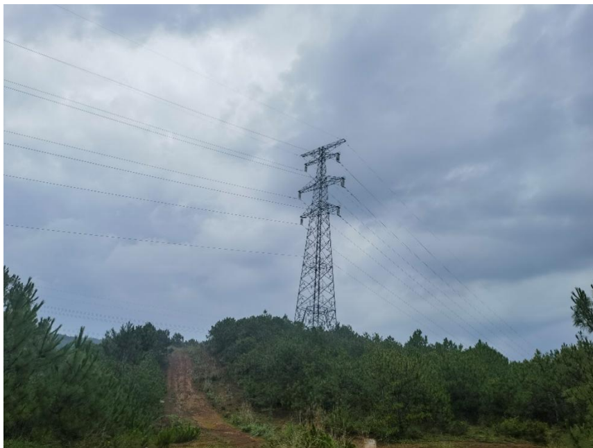
图 2.3-6 花椒门站北侧 110kV 高压电力线路
