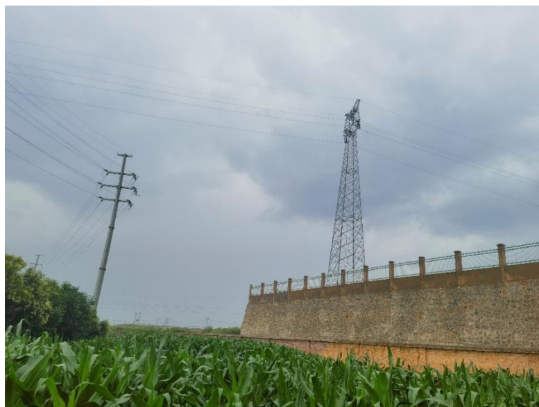
图 2.3-8 拟建凤凰山工业园区调压柜东侧高压线路
