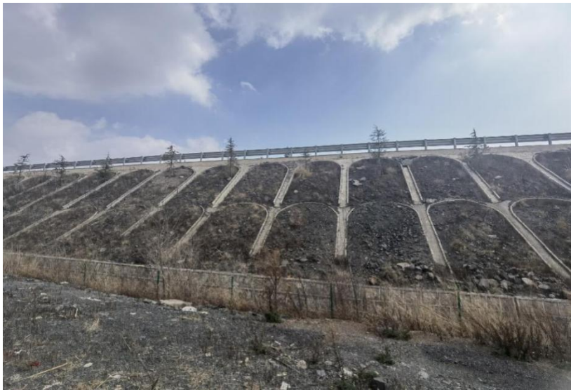
图 2.3-4 威宣高速路堤
