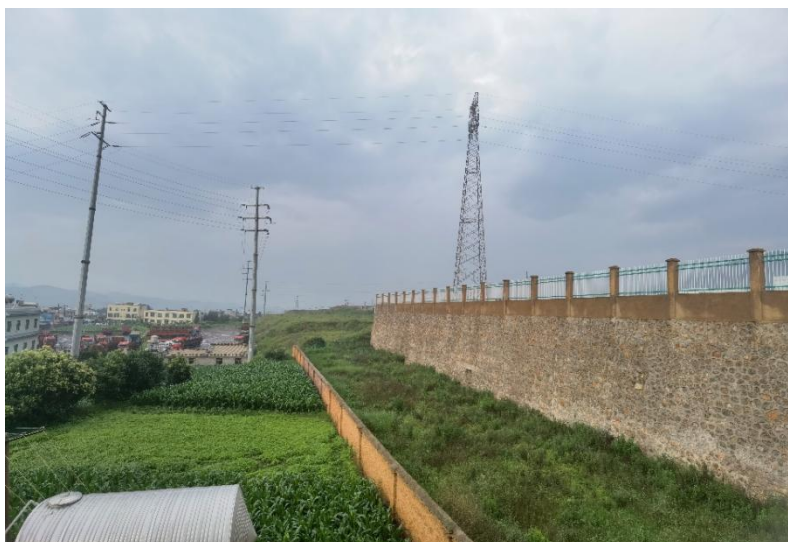
图 2.3-9 拟建凤凰山工业园区调压柜站址及男北侧挡墙（围墙）
